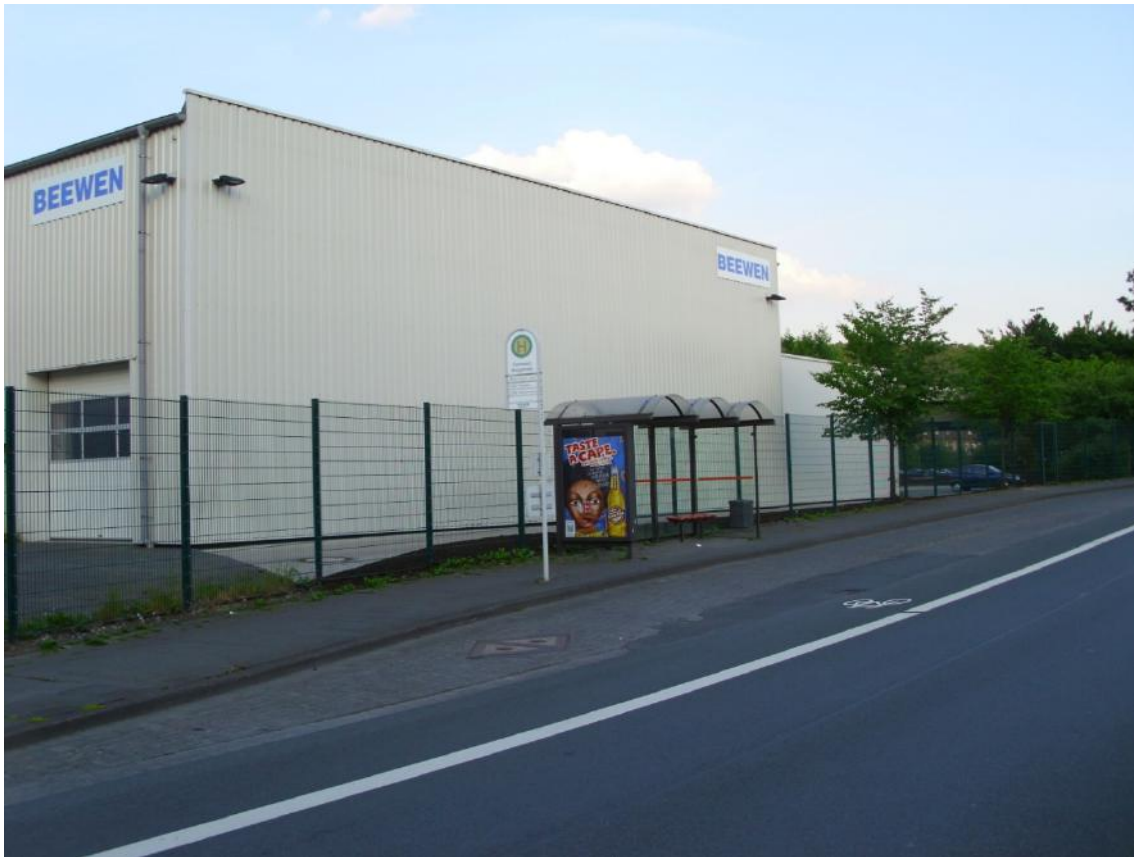
Abbildung 11 Haltestelle Geisweid Bergstraße (Fahrtrichtung Kreuztal) – vor dem Umbau
