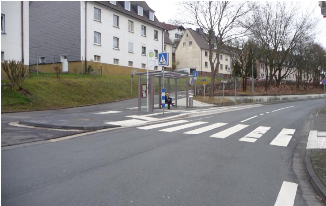
Abbildung 16 Haltestelle Siegen Siemensstraße (Fahrtrichtung Siegen) – nach dem Umbau
