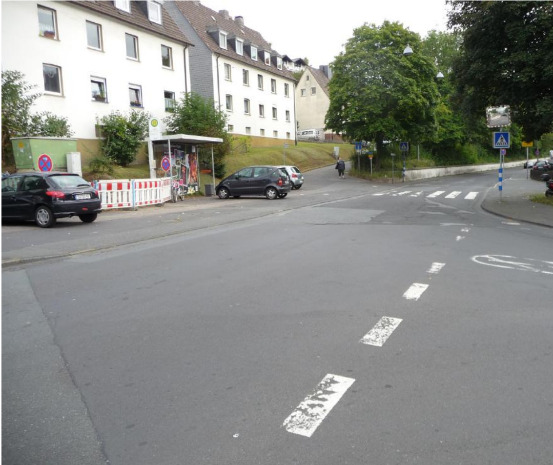
Abbildung 15 Haltestelle Siegen Siemensstraße (Fahrtrichtung Siegen) – vor dem Umbau
