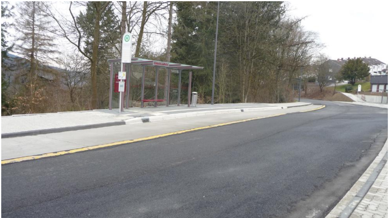
Abbildung 14 Haltestelle Weidenau Uni (H) Hölderlinstraße (Fahrtrichtung Uni) – nach dem Umbau
